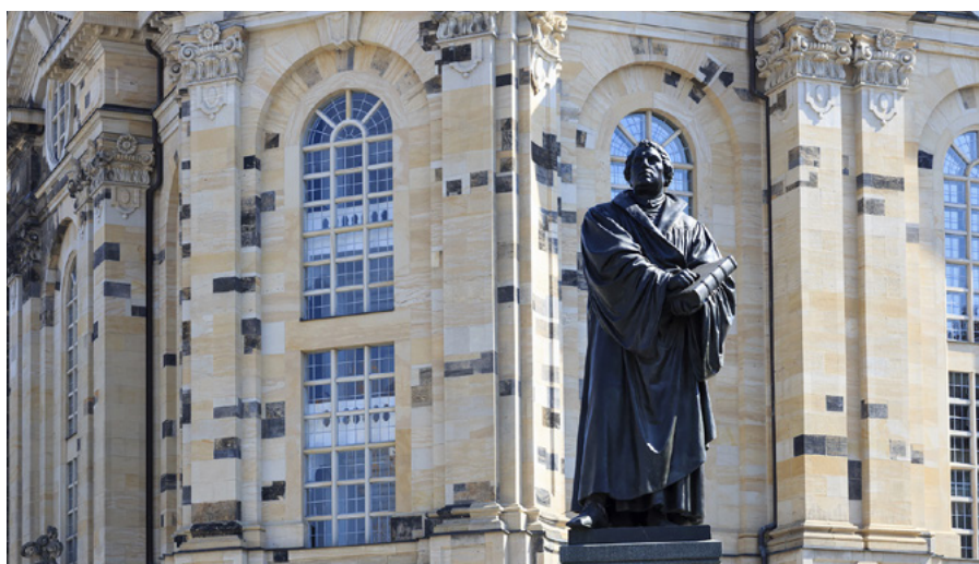
Ohněm zčernalé kameny, které byly použity při rekonstrukci luteránského kostela Frauenkirche, jsou pozoruhodným symbolem schopnosti člověka vytvářet nový život z popela.
