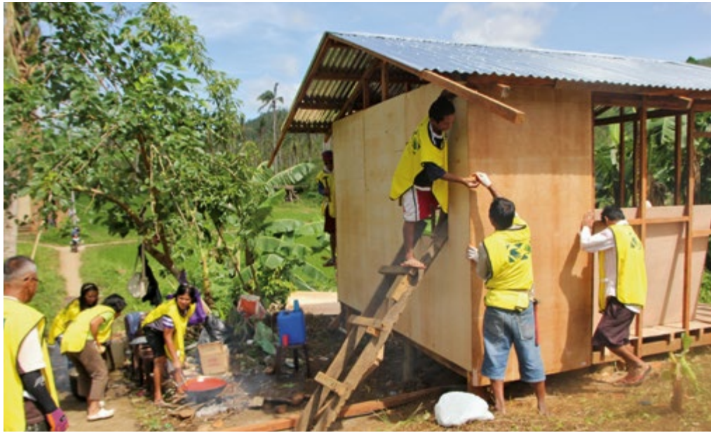
อาสาสมัครตอกไม้ติดกับโครงบ้านหลังใหม่ในตาโกลบัน ฟิลิปปินส์
