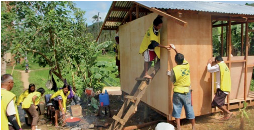
Vullnetarë duke ngulur kompensata në skeletin e një shtëpie të re në Takloban në Filipine.
