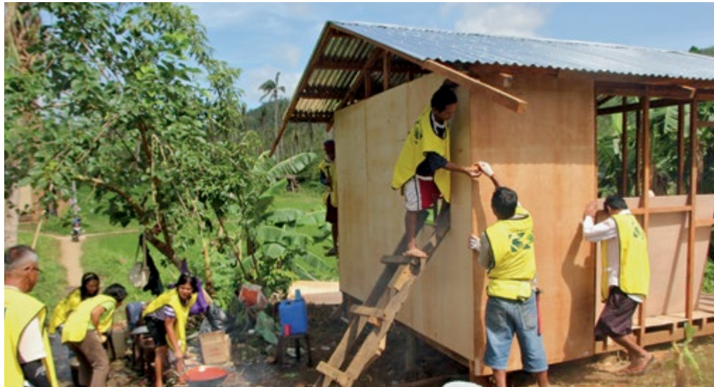
Vrijwilligers bevestigen multiplex aan het geraamte van een huis in Tacloban (Filipijnen).
