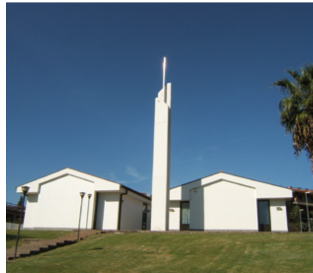
Дом собраний небольшого прихода в городе Катанья на сицилийском побережье. Небольшой приход в городе Катанья был организован в 1967 году, через год после организации Итальянской миссии.
