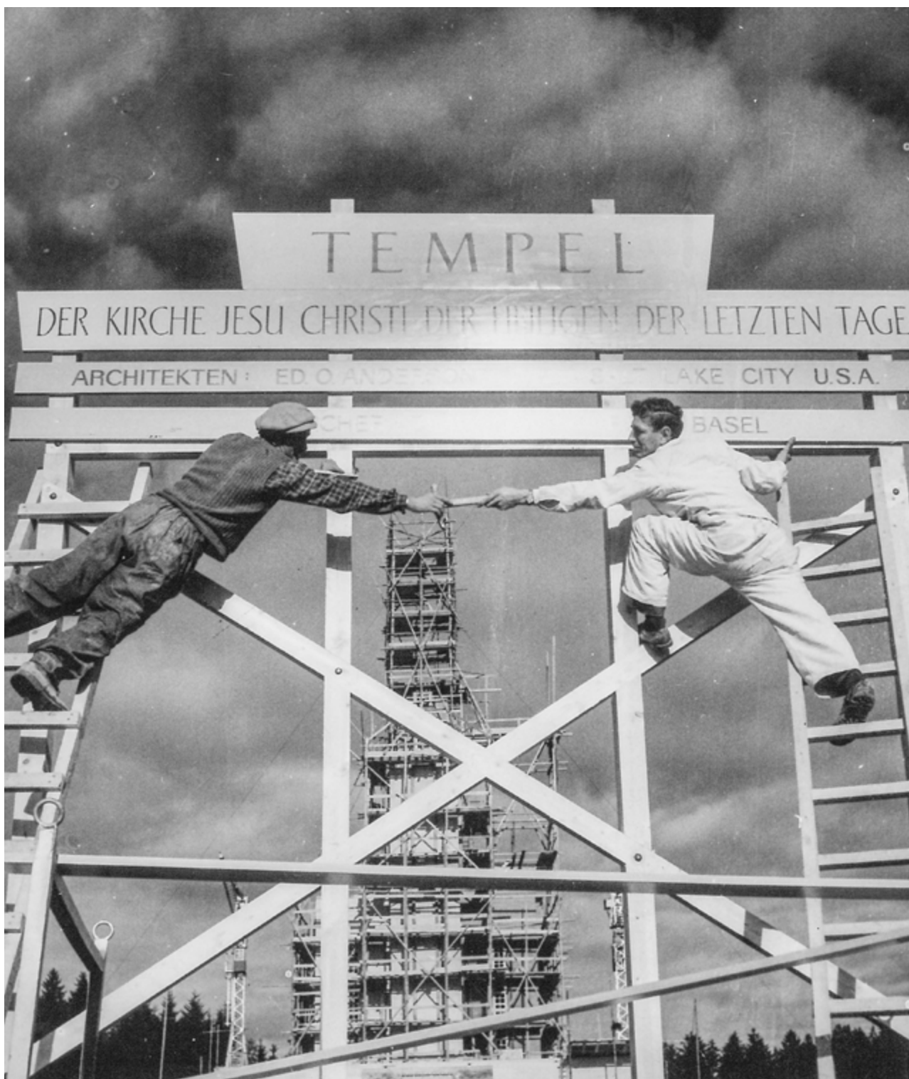
Рабочие устанавливают знак на строительной площадке храма в Берне, Швейцария. Этот храм посвятил в 1955 году Президент Дэвид О. Маккей. Это был первый храм за пределами Северной Америки, а также первый храм, где таинства стали проводиться не на английском языке.
