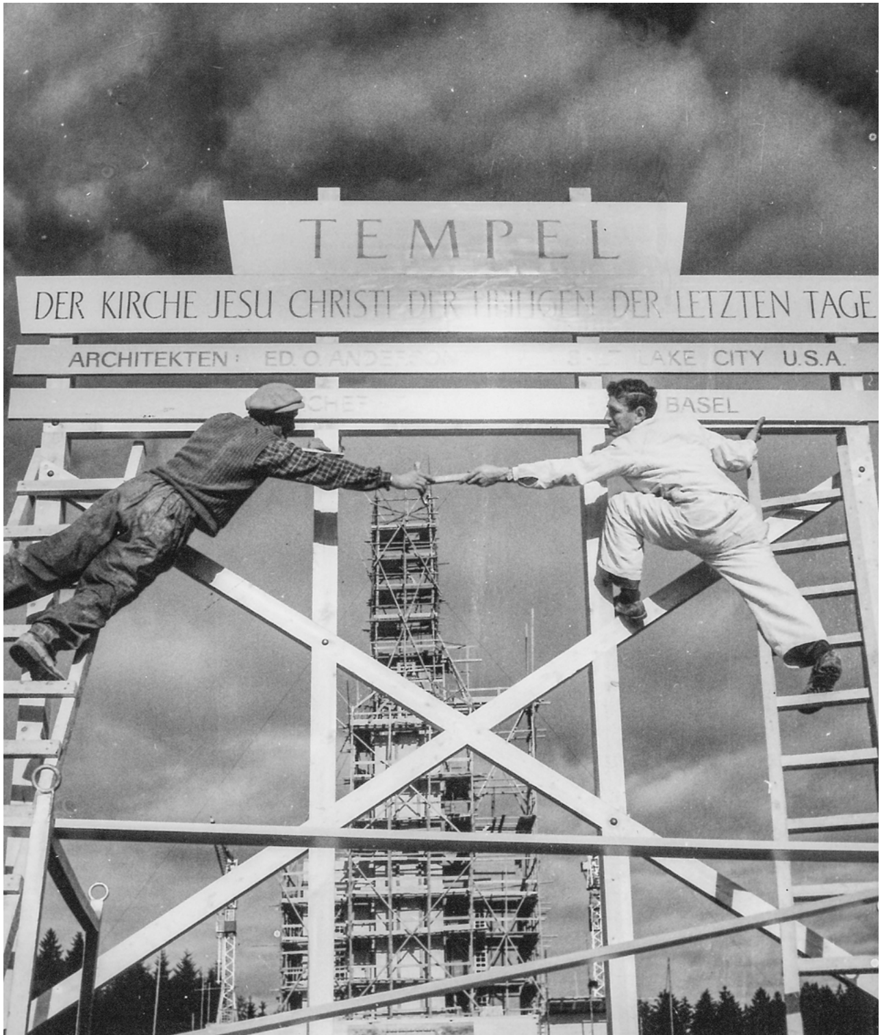
Bouwwerkers zetten op de bouwplaats van de Berntempel een bord in elkaar. De tempel is in september 1955 door president David O. McKay ingewijd. Het was de eerste tempel buiten Noord-Amerika en de eerste waarin de verordeningen in andere talen dan het Engels werden verricht.
