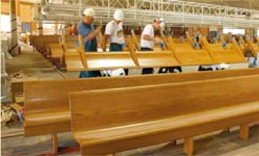
上——元の柔らかいマツの長いすの代わりに、堅いホワイトオークの長いすを取り付ける作業員。開拓者の職人たちがオーク材に見えるように手作業で塗装した元の長いすは、破損し、すり減っていた。元の長いす数点は常時展示される。
