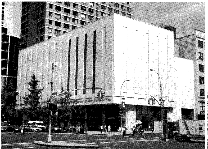
マンハッタンにある教会所有の建物はニューヨークで2番目の神殿となる。神殿は建物の上層フロアーに位置することになる。
