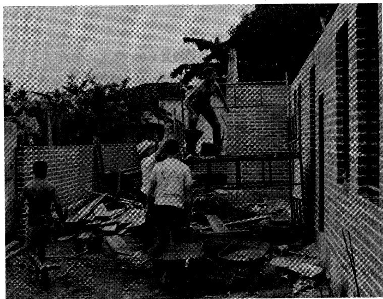
教会員による会堂建設
