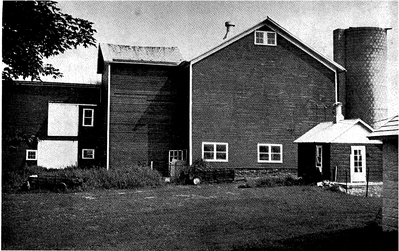
屋根と壁を一部修復したジョンソン家の納屋は、予言者の時代に建てられたものである。
