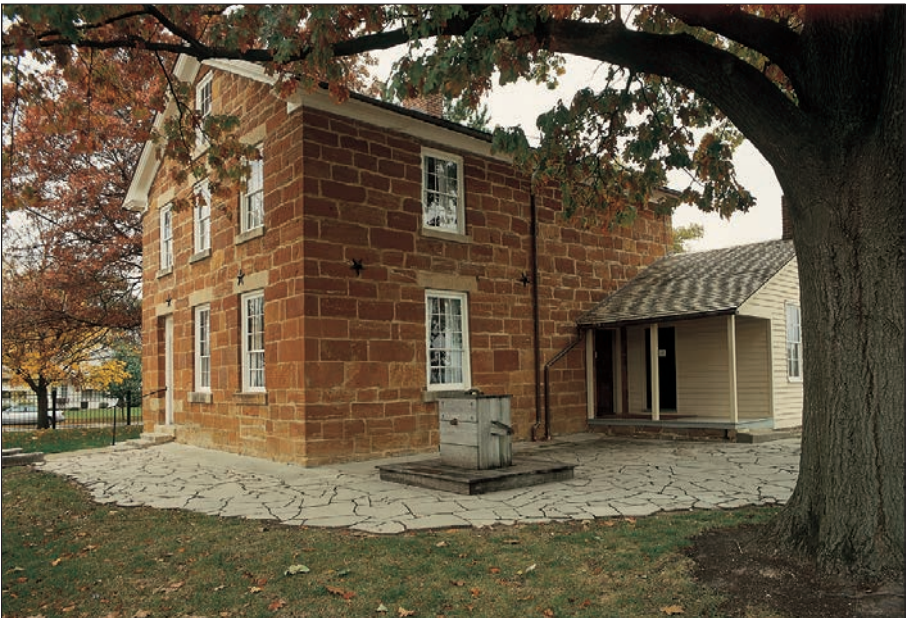
16. ՔԱՐԹԵԶԻ ԲԱՆՏԸ 1844թ. հունիսի 27-ին այստեղ նահատակվել են Մարգարե Ջոզեֆ Սմիթը և նրա եղբայր Հայրունը (տես՝ ՎԱՌԻ 135):
