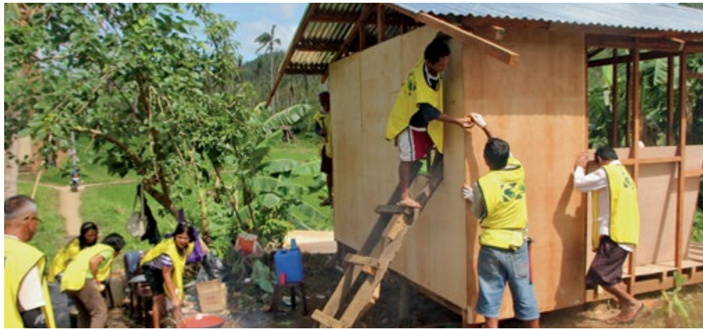
Волонтери прибивають дерев'яні дошки до каркасу нового будинку в Таклобані, Філіппіни.
