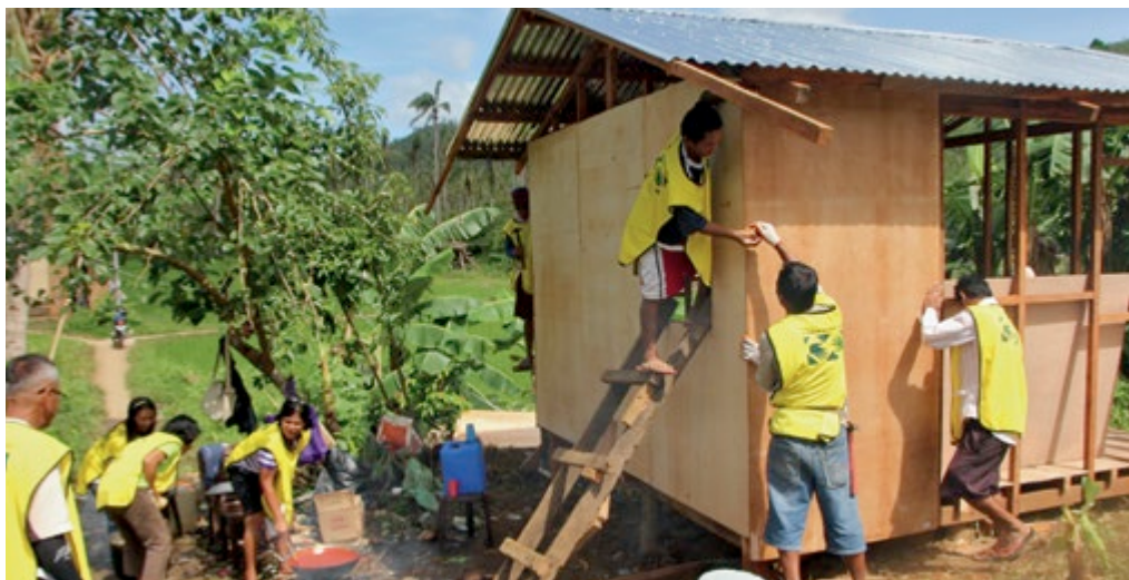
Fülöp-szigetek, Tacloban: önkéntesek furnérlemezeket szögelnek egy új ház vázára
