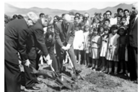
Führer der Kirche beim ersten Spatenstich für die Oberschule Benemérito de las Américas am 4. November 1963
