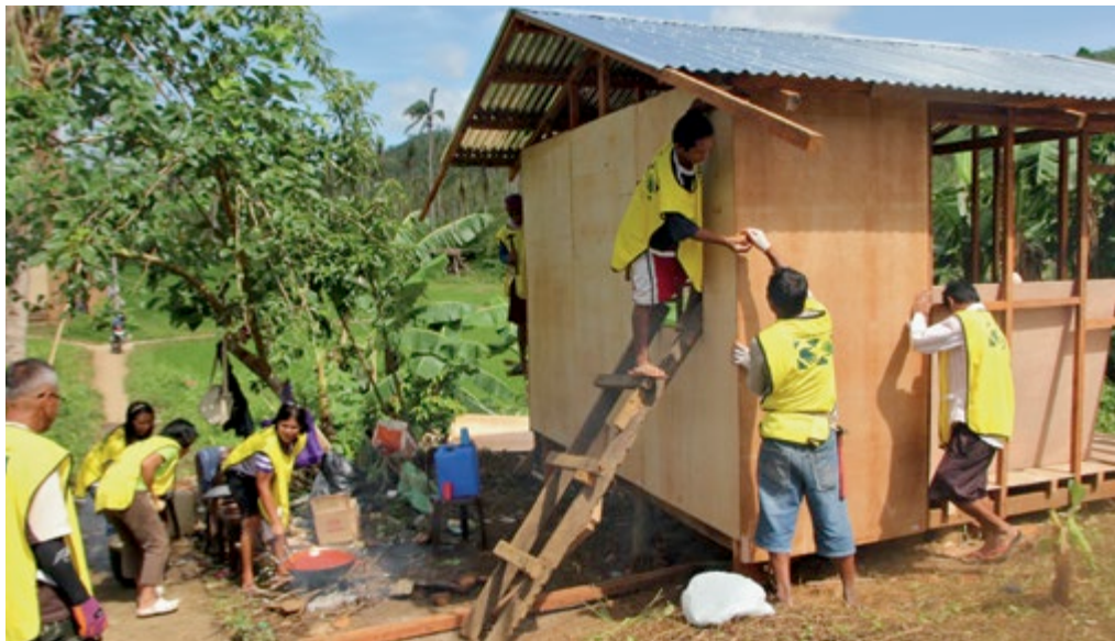
Voluntarii bat cuie într-un placaj fixat pe structura unei noi case în Tacloban, Filipine.
