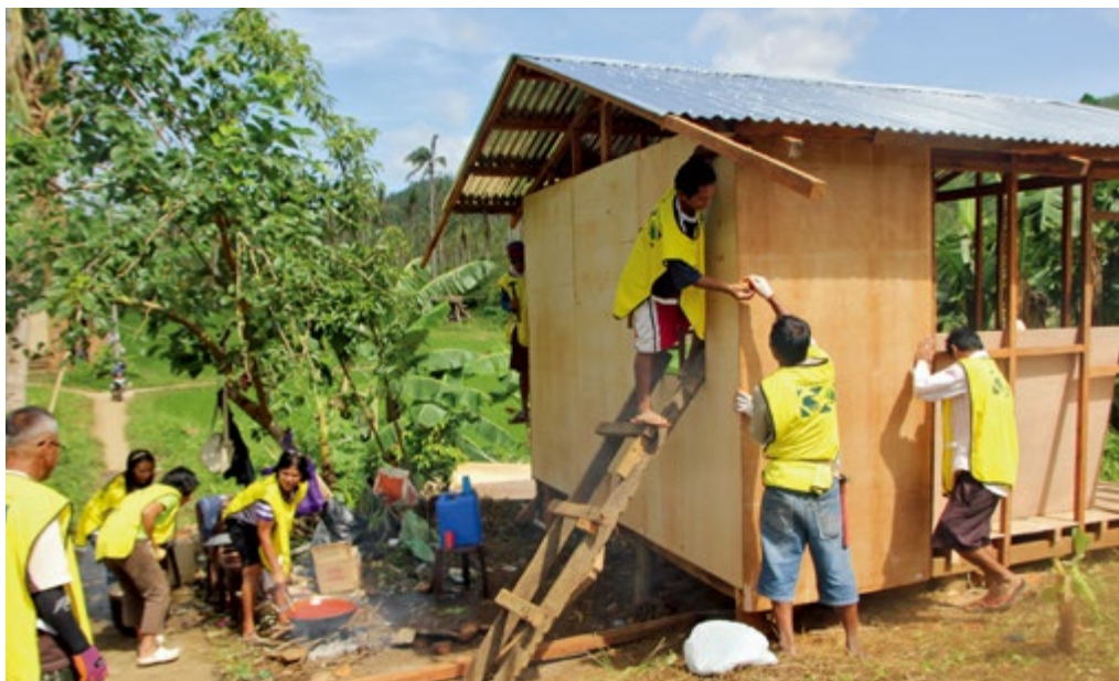
フィリピン、タクロバンで新しい家の骨組みに合板 くま を釘で打ちつけるボランティア。
