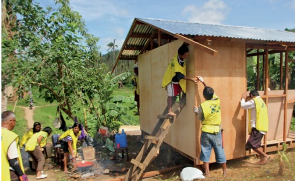
Freiwillige Helfer befestigen Sperrholzplatten an den hölzernen Trägern eines Neubaus im philippinischen Tacloban
